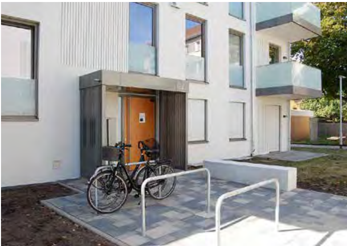
Die Eingangsbereiche sind bereits mit Fahrradständern ausgestattet.
