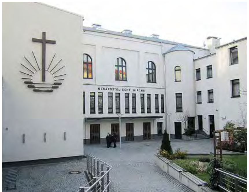
Bis vor kurzem nutzte die Neuapostolische Kirche Teile des Gebäudes.
