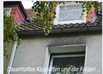
Durch die niedrigen Außentemperaturen wird das Mauerwerk des auf Dauer gekippten Fensters stark ausgekühlt. Besonders im Bereich des Fenstersturzes entsteht für Schimmel die beste Voraussetzung, um wachsen zu können. Denn die Feuchtigkeit in der Raumluft schlägt sich immer an den kältesten Stellen im Raum nieder und kondensiert, in diesem Fall direkt über dem Fenster.
