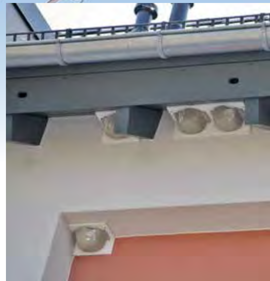
Modernisierung mit Vogelschutz: Nistplätze und Einfluglöcher für Schwalben und Mauersegler an den Dachtraufen
