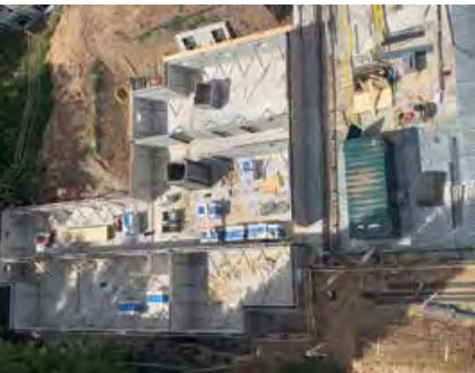
Das Kellergeschoss und die Tiefgarage befinden sich bereits im Ausbau.
