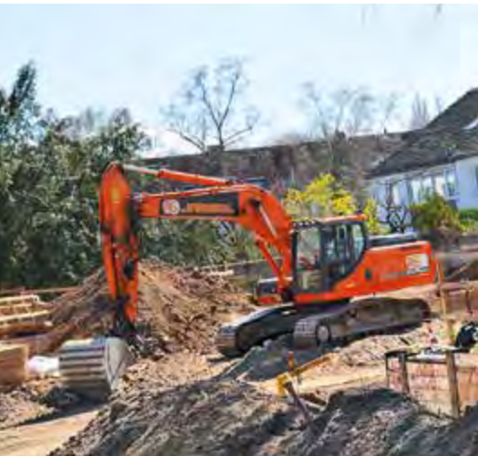
Die Baugrube im Ausbau Anfang April 2020
