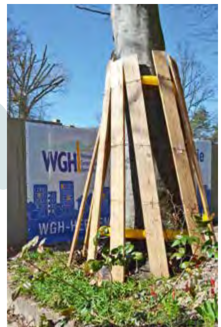
Der auf dem Grundstück vorhandene Baumbestand wird zum Schutz eingeschal.
