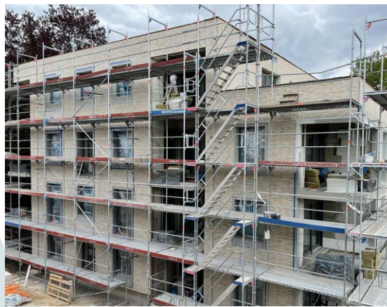
Der Einbau der Fensterelemente und die Klinkerfassaden sind bereits fertiggestellt.
