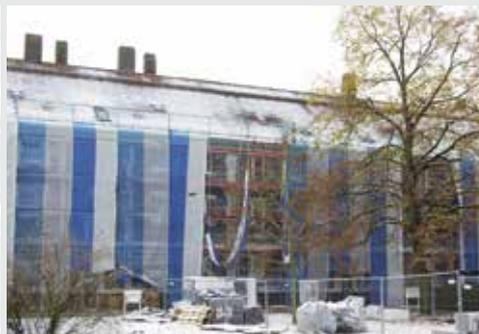
Oben: Auf der Hofseite in der Eilser Masch werden die Fassaden bereits gedämmt und farblich neugestaltet.
